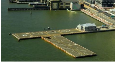
Abb. 4 Vertiport auf einem Ponton
